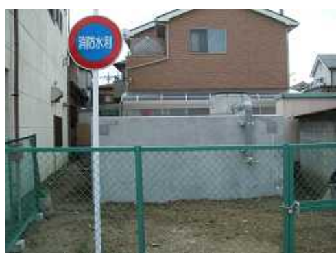
西原団地内に新設されたタンク形式の防火水槽
