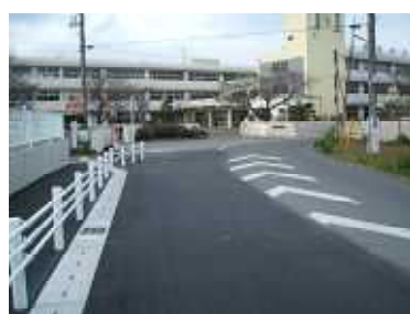
広く改良された泉野小学校正門前
