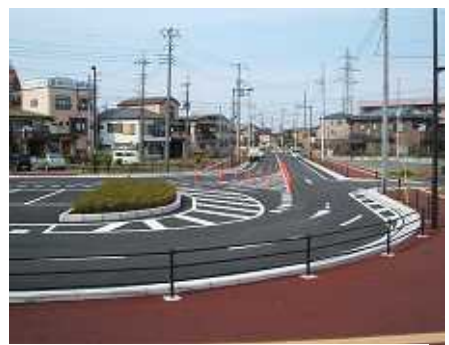
完成した長瀬駅北口ロータリー付近
