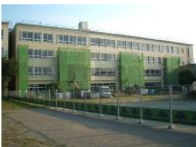
夏休みに入り、耐震補強工事が始まった川角中学校校舎
